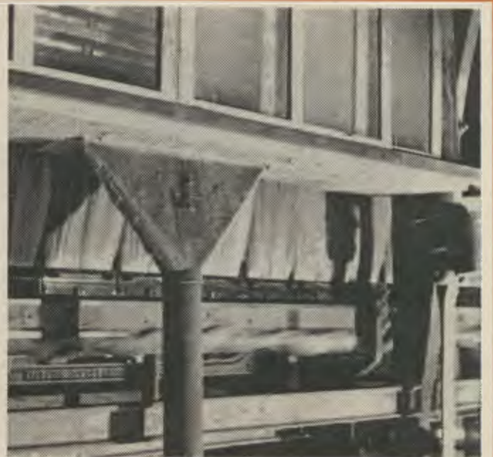
5 Das Hecheln bereitet den Spinnvorgang vor. Mit einer engen Zahneinstellung werden dabei die letzten Kurzfasern aus dem Flachs gekämmt, die allerfeinsten „Schäben“ zwischen den Fasern beseitigt.
