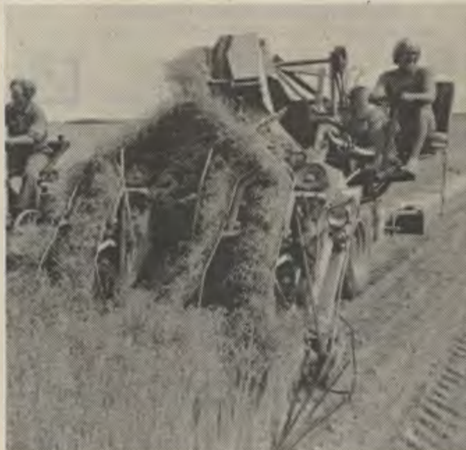
2 Wenn der Flachs im Gelbreife-Stadium ist, wird er geerntet. Er muß „gerauft“ werden, das heißt, mit samt der Wurzel büschelweise aus dem Boden gezogen. Heute erledigen das leistungsfähige Maschinen.
